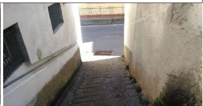
Regimazione dell'impluvio a NO di Magnot con fosso a monte dell'impluvio e griglia di raccolta dell'acqua di ruscellamento prima della strada asfaltata, e al termine del vicolo su via XI Febbraio
