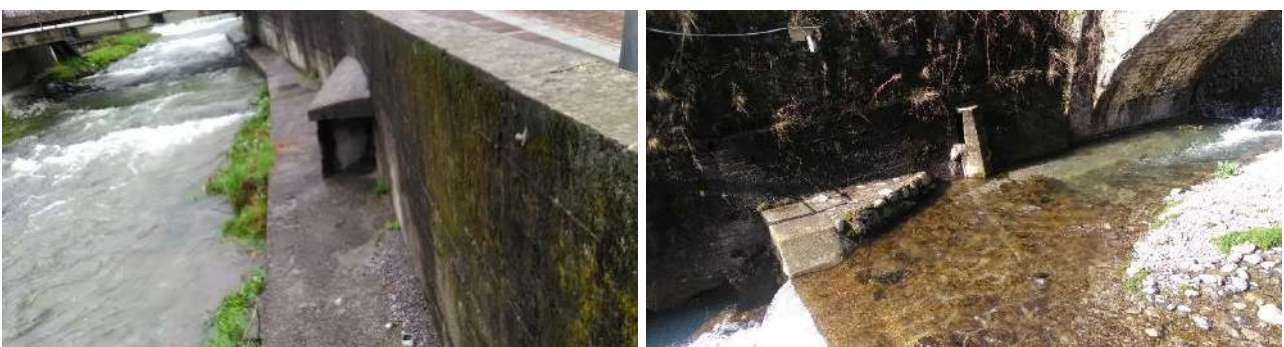
Sfioratore S17 in sponda sinistra del Vertova (a sinistra) presso ponte Martina e sfioratore S39 in sponda destra del Vertova presso ponte S. Carlo)
