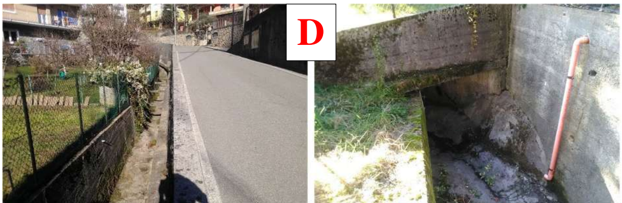
A) Tratto torrente Cereti a monte dell'area urbanizzata con briglia in legname; B) Inizio primo tratto intubato al di sotto di via degli Alpini e via Cereti; C) via Cereti sotto cui scorre il torrente e uscita tratto intubato sotto via Cereti; D) tratto incanalato a lato di via Cereti e ingresso tratto intubato sotto via Pianoro
