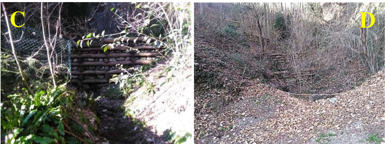
Briglie. In cemento rivestite in pietrame lungo il torrente Vertova (A) e lungo la valle di Lacnè (B), quest'ultimo a protezione dell'attraversamento stradale per l'accesso alle caccine di Castelù e limitrofe. In legname e pietrame nella parte media alta della valle dei Cereti a monte del centro abitato (C) o a monte di un attraversamento con piccolo tombotto nella valle degli Uccelli (D)
