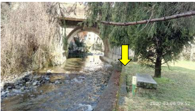
Muri spondali lungo il torrente Vertova all'interno del centro abitato: le frecce indicano alcuni dei punti dove vi sono ringhiere non in continuità con i muri o muri spondali di altezza insufficiente
