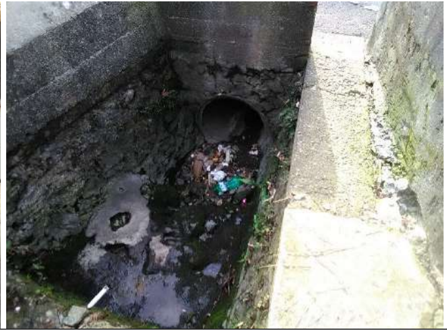
Il rio Boisi con l'inizio del tratto intubato sotto via 5 Martiri e l'area industriale ex Bustese (in alto) e le operazioni di pulizia a seguito dell'evento del luglio 2020 che hanno messo in luce le caratteristiche dell'attraversamento (in basso)
