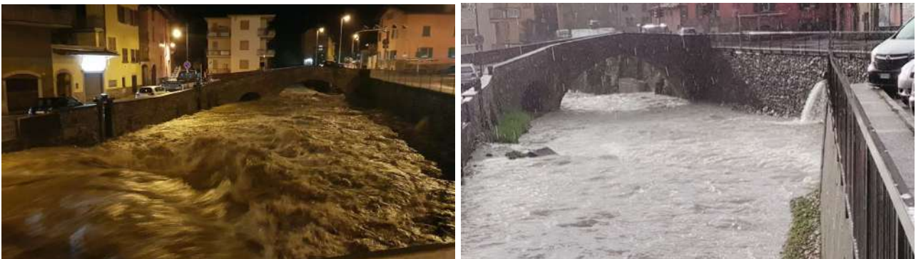
Sfioratore S18 durante due eventi di piena del torrente Vertova (a sinistra 29 .05.2018) fiume Serio)
