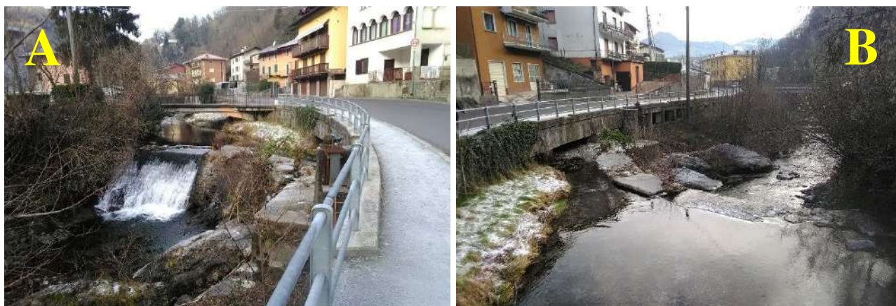
Roggia degli Edifici: l'opera di presa con la soglia di derivazione (A) e l'inizio del canale sotto via 5 Martiri (B); il primo rilascio presso l'area industriale ex Bustese (C) e quello finale a valle del lavatoio di piazza San Lorenzo nel torrente Vertova
