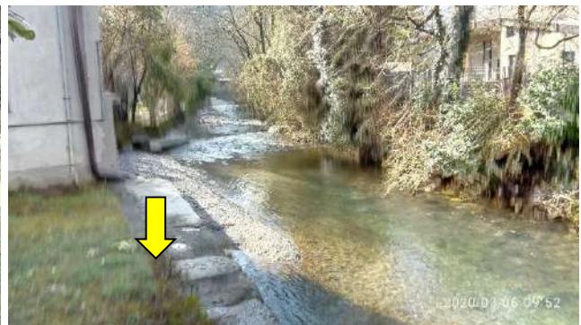
Muri spondali lungo il torrente Vertova all'interno del centro abitato: le frecce indicano alcuni dei punti dove vi sono ringhiere non in continuità con i muri o muri spondali di altezza insufficiente
