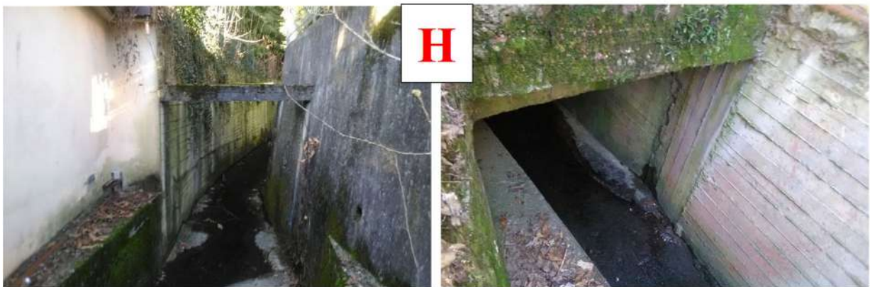
E) Uscita sotto via Pianoro e tratto a lato del bacino di via Cereti; F) Tratto a valle del bacino di via Cereti e ponte di via Divisione Tridentina; G) ponte di via Divisione Tridentina visto da valle e tratto tra muri immediatamente a valle del ponte; H) tratto incanalato a monte di via Cadelora e imbocco tratto intubato sotto la via.
