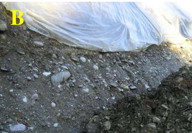
Scavi o spaccati sui terreni alluvionali e fluvio-glaciali su cui è ubicato l'abitato di Vertova: A) spaccato della frana del muro di via IV Novembre con riporti e terreno fluvio-glaciale; B) scavo presso rotatoria SS671; C) scavo nel campo sportivo di Vertova per la realizzazione delle torri faro in cui si nota il materiale ghiaioso ciottoloso sciolto o in matrice limoso sabbiosa.
