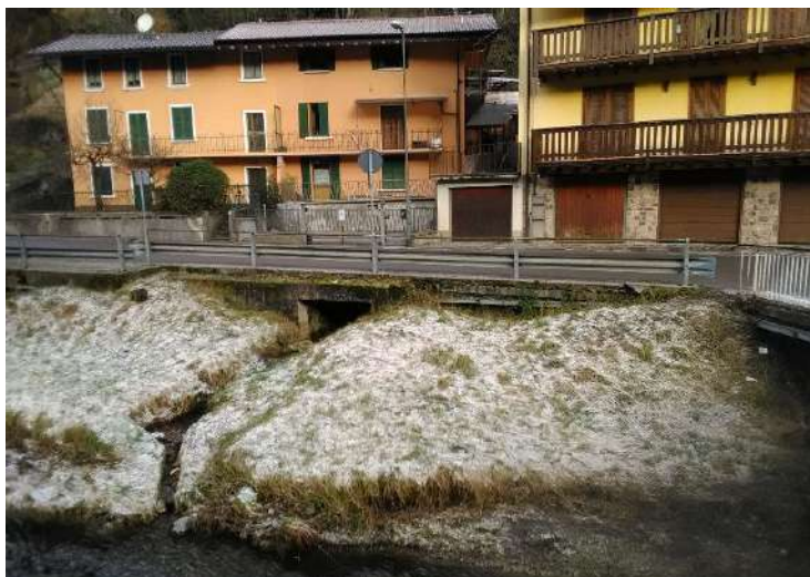
Il rio Boisi che si immette nel torrente Vertova con edifici a ridosso dell'alveo e autorimessa sopra il rio appena a monte del tombotto di via 5 Martiri
