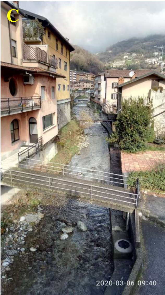
Tratti di fognatura lungo l'asta del torrente Vertova con tombini al di sotto del livello di piena (A, B, C) e tratti di fognatura lungo la valle dei Cereti (D, E)
