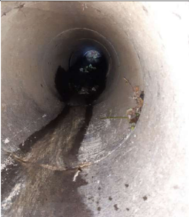
Il rio Boisi con l'inizio del tratto intubato sotto via 5 Martiri e l'area industriale ex Bustese (in alto) e le operazioni di pulizia a seguito dell'evento del luglio 2020 che hanno messo in luce le caratteristiche dell'attraversamento (in basso)
