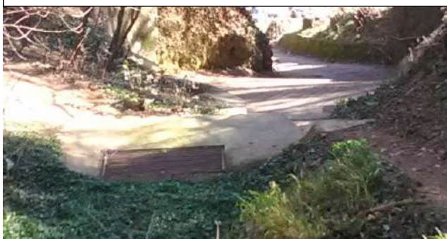
Regimazione dell'impluvio a NO di Magnot con fosso a monte dell'impluvio e griglia di raccolta dell'acqua di ruscellamento prima della strada asfaltata, e al termine del vicolo su via XI Febbraio
