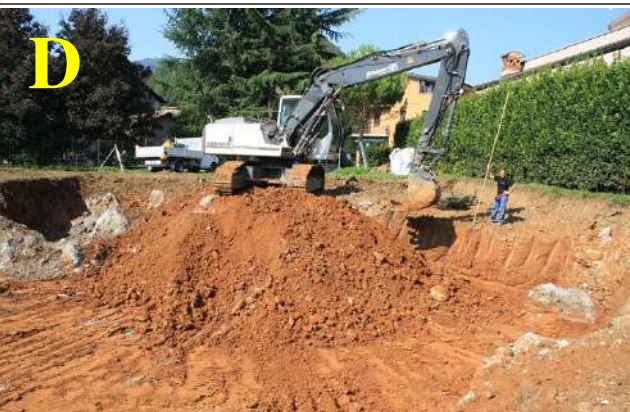
Terreni limo sabbiosi con ciottoli che ricoprono la roccia in via Rimembranze 6 (D) o sulle scarpate per Polecc (E)
