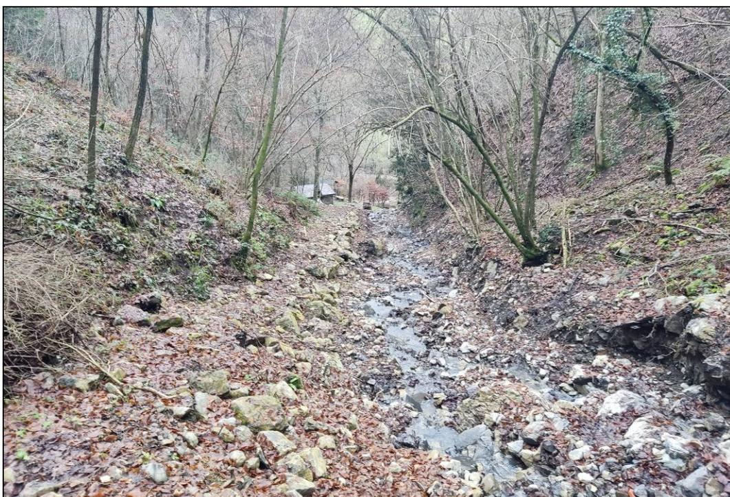
Foto 7: Vista da monte del tratto terminale dell'incisione valliva sottostante i dissesti che hanno interessato la scarpata di valle della strada che conduce in Val di Grù. Si nota il materiale tolto dall'alveo ed addossato in sinistra per realizzare una protezione spondale.
