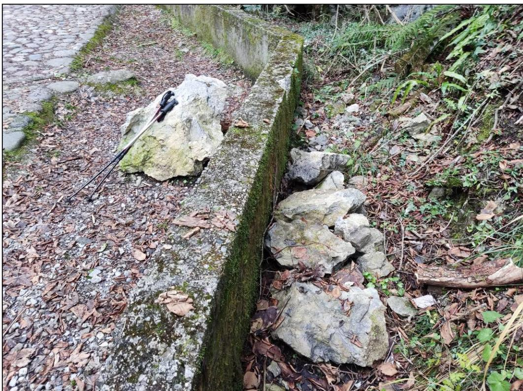
Foto 70: Blocchi di un crollo recente che ha lesionato un muretto della strada di servizio che percorre il fondovalle: il masso che ha oltrepassato il muretto ha un volume di  $0.1 \text{ m}^3$  (versante sinistro, circa 90 m a valle del 1° "guado con passaro").
