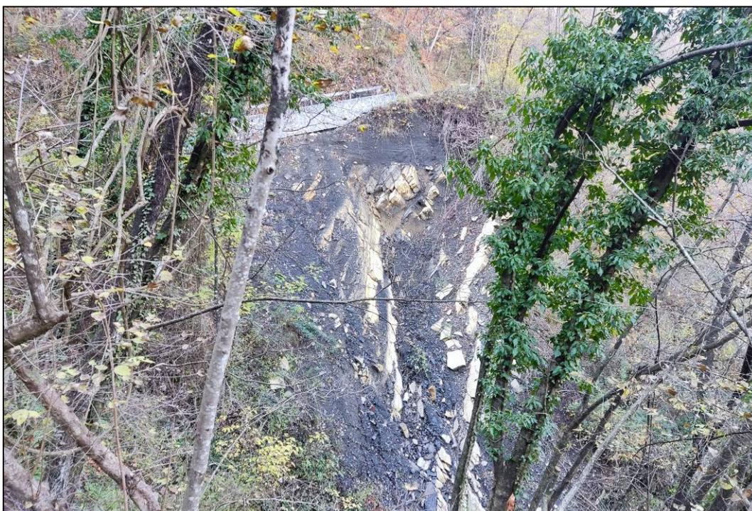
Foto 5: Vista sul dissesto più recente che ha interessato la scarpata di valle della sede stradale che conduce in Val di Grü, a poche decine di metri di distanza da quello avvenuto nel 2019.
