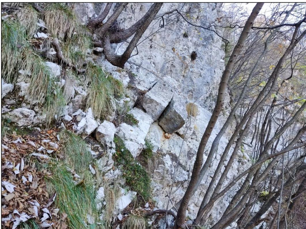
Foto 17: Piccoli blocchi instabili per scivolamento planare su discontinuità disposta a franapoggio (zona RS5).
