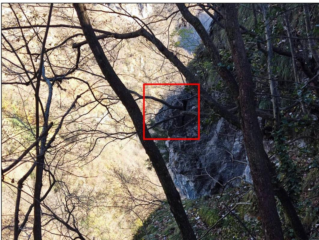
Foto 53: Blocco di circa 1 m<sup>3</sup> completamente isolato e parzialmente a sbalzo, poggiante su un piccolo gradino; può crollare a causa della spinta delle radici che crescono nella frattura a tergo (ciglio del versante destro, zona sovrastante il 1° "guado con passerai" della strada di servizio che percorre il fondovalle).
