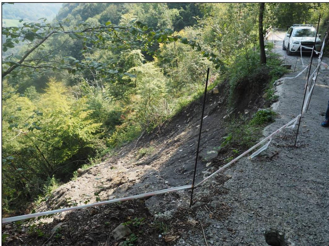
Foto 3: Nicchia di distacco del dissesto che nel 2019 ha interessato la scarpata di valle della sede stradale che conduce in Val di Grü.
