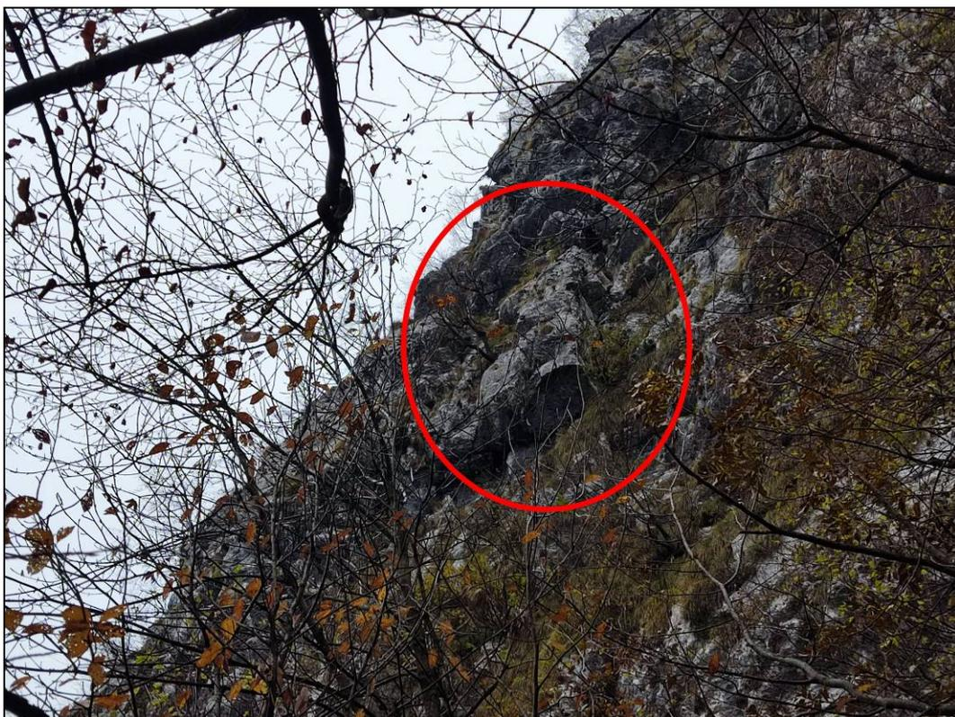
Foto 31: Porzione d'ammasso in aggetto, suddivisa in più blocchi di grandi dimensioni (stima di quelli di volume maggiore  $6\div 8\text{ m}^3$ ), parzialmente isolata a tergo da una frattura molto aperta (zona tra RS10 e RS11, parete nord del M.Cedrina costituita dalle litofacies della Fm. Dell'Albenza).
