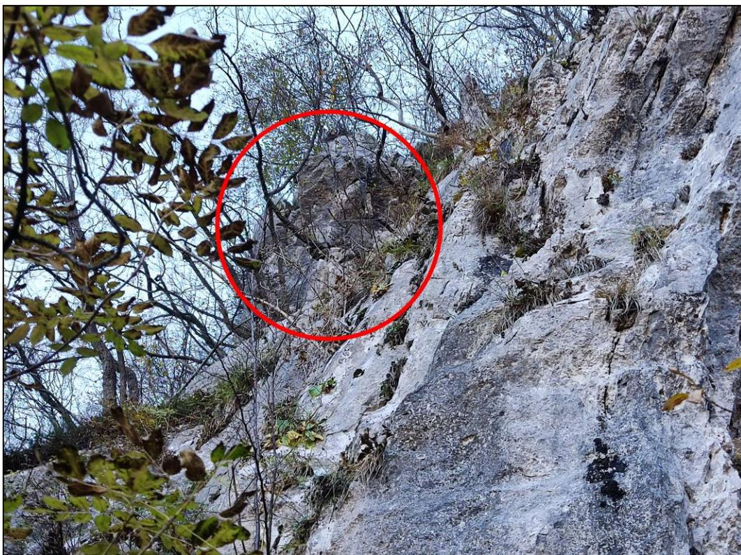
Foto 16: Ammasso di blocchi instabili che possono mobilizzarsi per scivolamento planare, quello di maggiori dimensioni ha un volume stimabile in  $\approx 3 \text{ m}^3$  (zona RS4).
